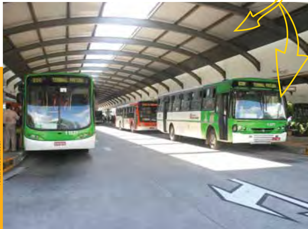
Terminal de ônibus urbanos da Lapa, na zona oeste, concluído em 2003. O projeto buscou estabelecer um diálogo entre a obra e seu entorno, onde estão situados o Museu de Ciências da USP, o Mercado Municipal, o Shopping Center Lapa, o viaduto sobre a linha férrea e a estação de trem metropolitano
