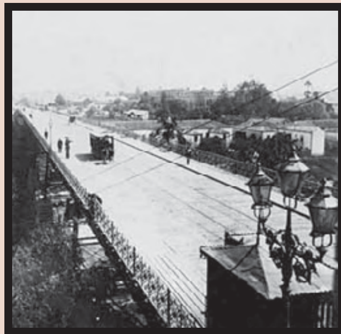
Fotografia tomada entre 1892 e 1893 do Viaduto do Chá. Em 1º plano, as casinhas em que ficavam os encarregados pela cobrança da taxa de pedágio: 60 reis por pessoa e, para os veículos, valores diferentes conforme o tipo: duas ou quatro rodas, de carga, etc.). Em último plano, o início da Rua Barão de Itapetininga
