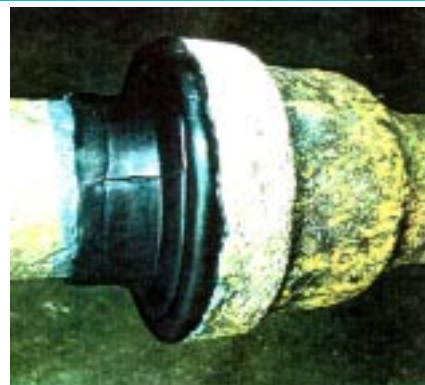
Esquema de vedação da junta da tubulação com juta e chumbo. Ao lado uma junta reparada.
