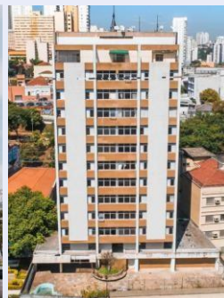
Condomínio Edifício Verde Cambuci - Rua do Lavapés, 1045, retrofitado pela Ilion Partners
