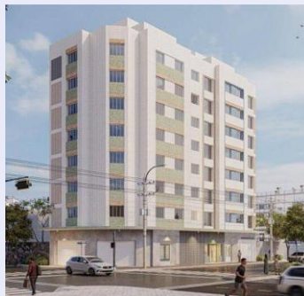
Edifício Yuca Maranta retrofitado pela YUCA, localizado na Av. Pedroso de Moraes, 221 - Pinheiros
