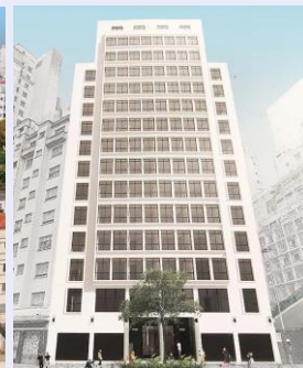
Edifício Maria Magdalena retrofitado pela Ilion Partners, localizado na Praça da Bandeira, 61
