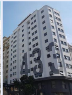
Uliving 433, retrofit na avenida Duque de Caxias
